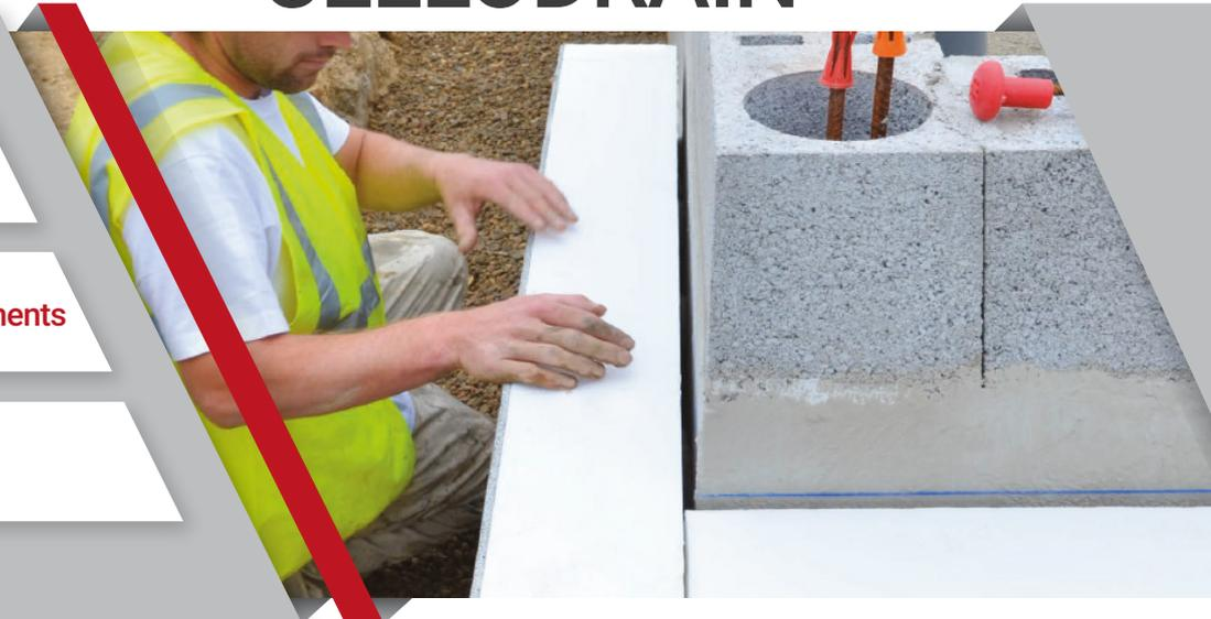
Panneau à bords feuillurés Celldrain® en polystyrène expansé de forte densité, spécialement conçu pour une application en partie enterrée. Constitué de plots drainants ainsi que d'un parement en textile filtrant, Celldrain® permet d'isoler thermiquement la paroi et de drainer les eaux pluviales.
