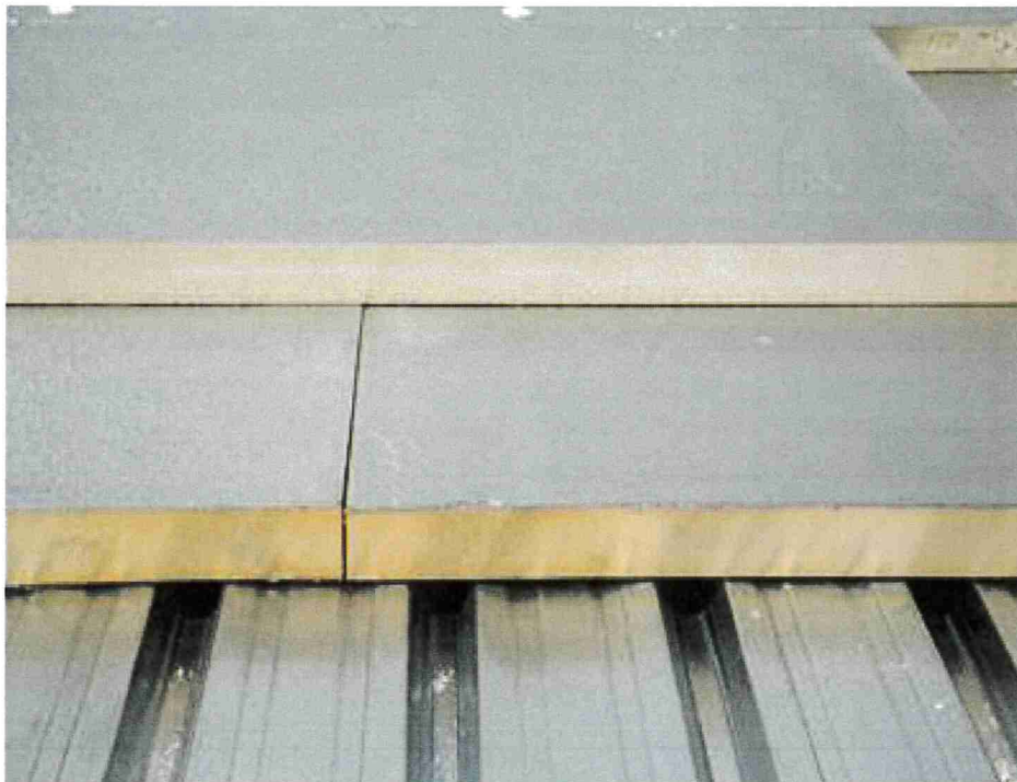
Photo : Pose de l'EuroTAN sans écran thermique perlite sur TAN
