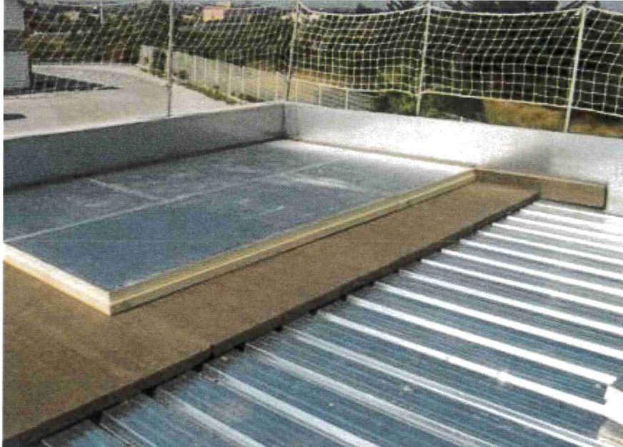
Photo : Pose de l'EuroTAN avec écran thermique perlite sur TAN
