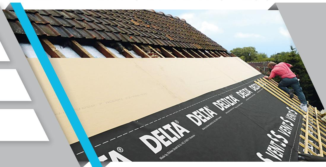
Écran de sous-toiture HPV R2 avec technologie bi-composants, hautement perméable à la vapeur d'eau. Association tri-couche de deux géotextiles en polypropylène et d'un film respirant intermédiaire en polypropylène.
